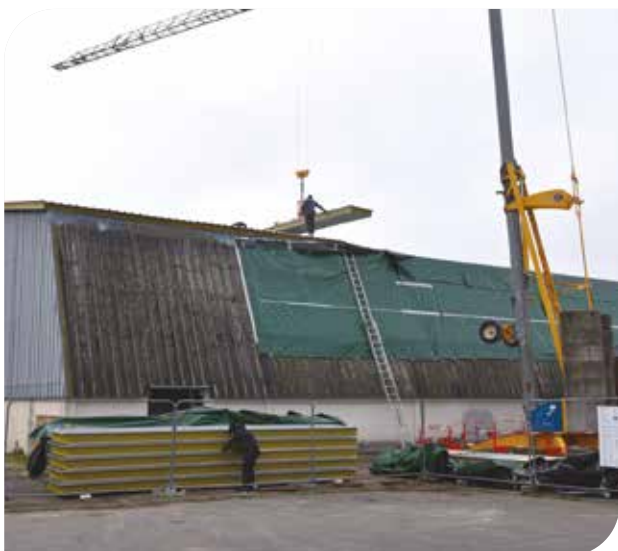
Au début des travaux
