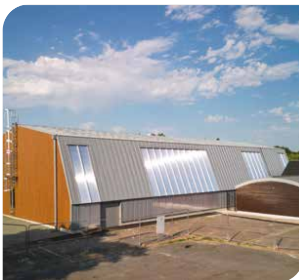
Après les travaux
